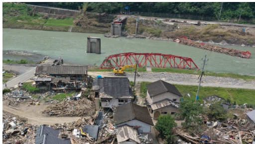
【熊本豪雨】被害が出た家屋がそのままの状態が残る球磨川流域 提供:産経新聞社
