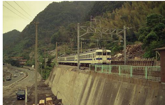
復旧してすぐの頃の日豊本線竜ヶ水駅付近
